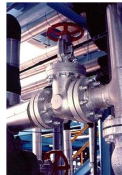
El Antes y el Después de la Rehabilitación de una Válvula y Tuberías Bajo Aislamiento Térmico, ahora usando pinturas resistentes a la condición
