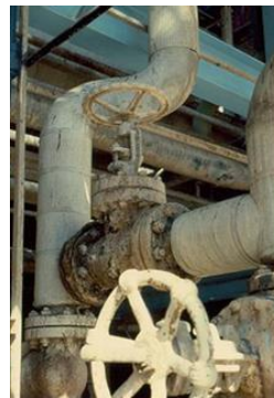
El Antes y el Después de la Rehabilitación de una Válvula y Tuberías Bajo Aislamiento Térmico, ahora usando pinturas resistentes a la condición
